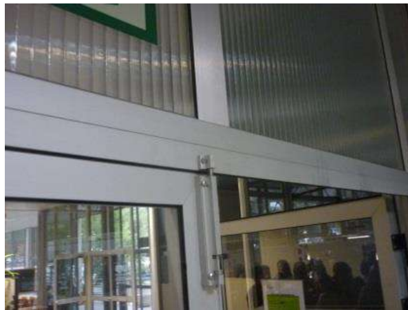
Foto 30. Porta sortida aulari-vestíbul mòdul nord
