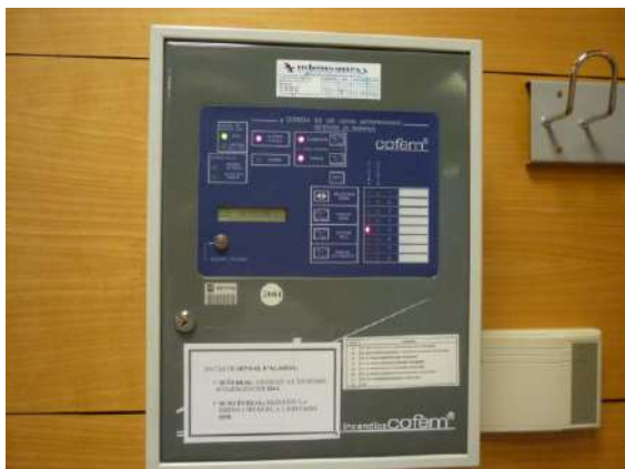
Fotos 23 i 24 . Central de detecció i alarma a Mòdul Sud i Mòdul Nord
