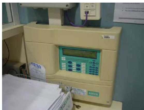
Fotos 23 i 24 . Central de detecció i alarma a Mòdul Sud i Mòdul Nord
