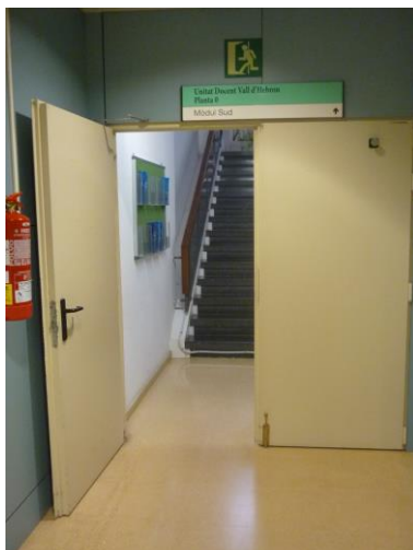
Foto 20. Porta que limita sector d'incendi
