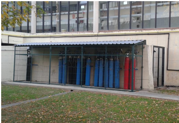
Caseta de gasos.
