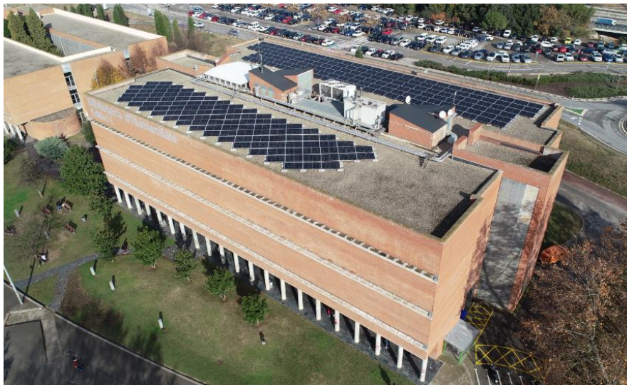
Fotografia 3. Planta solar fotovoltaica Biblioteca d'Humanitats, 2022.
