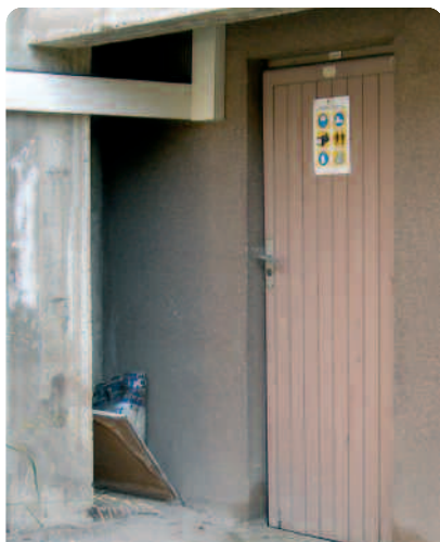
Para acceder a las galerías de servicios se deben respetar las indicaciones de seguridad.
