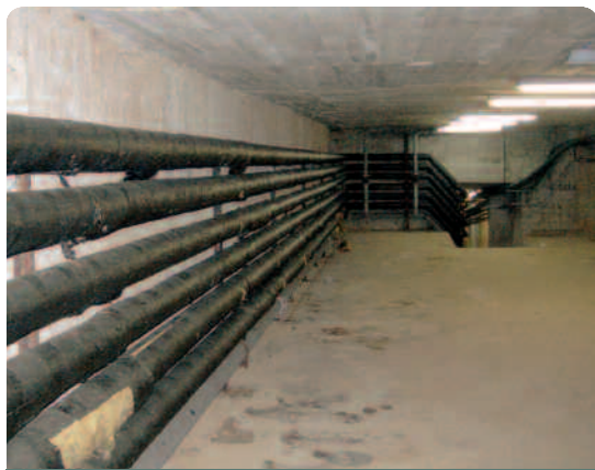
Espacios confinados. Galerías.
