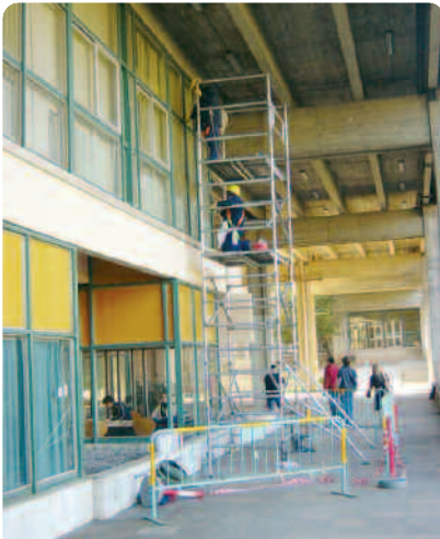
Es importante delimitar las zonas de trabajo que puedan afectar a terceras personas.
