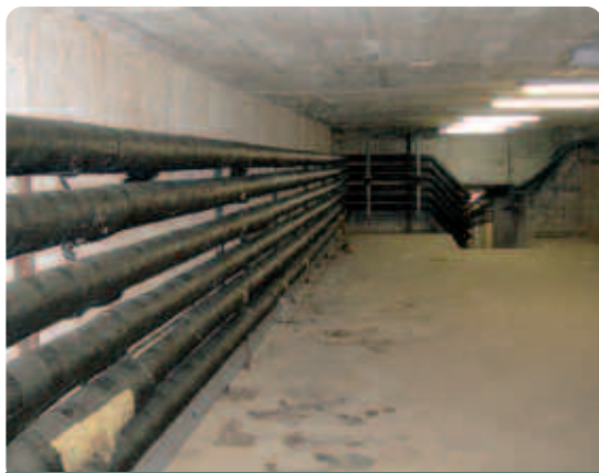
Espais confinats. Galeries.
